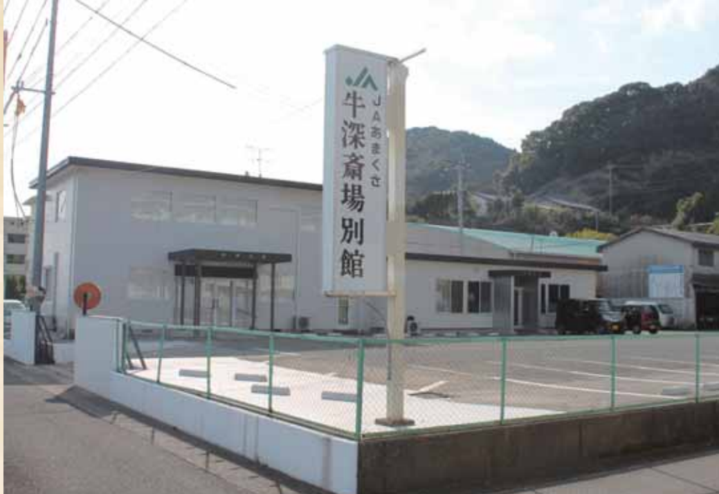
▲完成した牛深斎場
